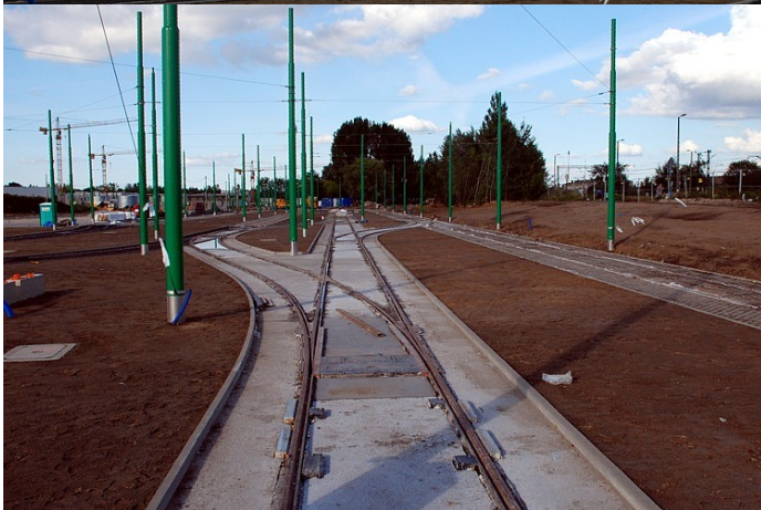
Zajezdnia Franowo w budowie.
