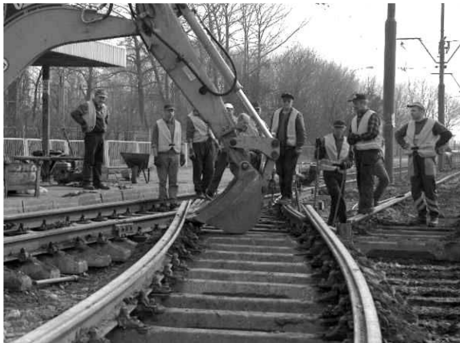
Oryginalna, koparkowa technika naginania torów – budowa łącznika przy rondzie Starołęka. Fot. Adam Biafas
