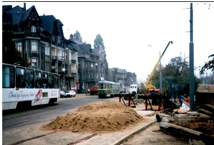
Budowa łącznika PST z siecią miejską.
